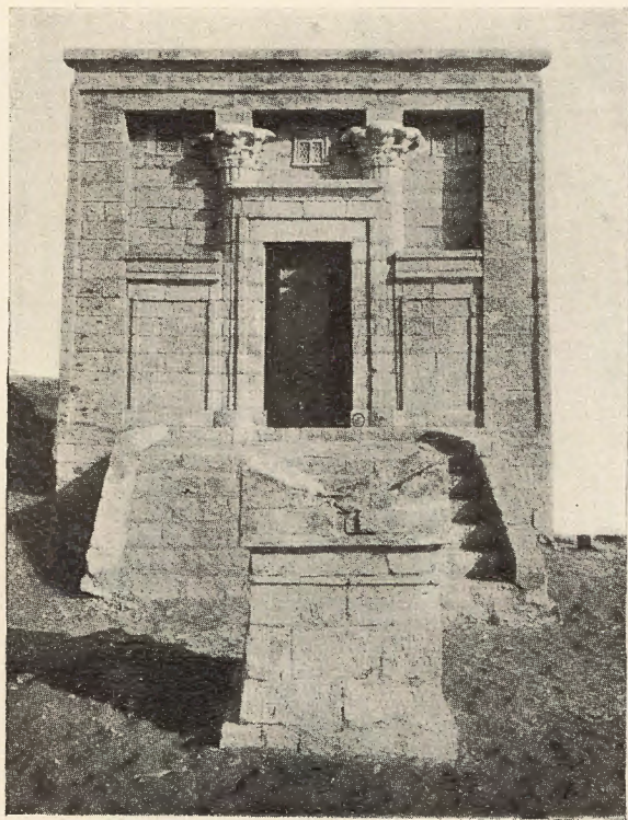
a) Temple de style ptolémaïque hissé sur une terrasse avec les fenêtres à treillis.
